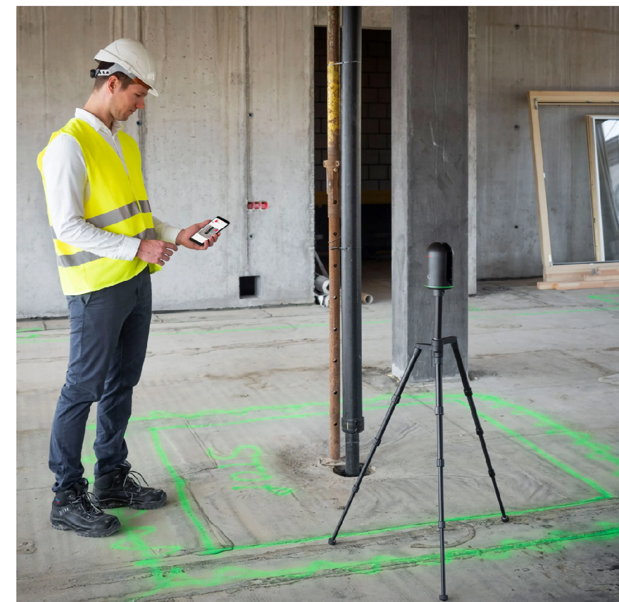
Strumentazione in campo durante le fasi di rilievo.
