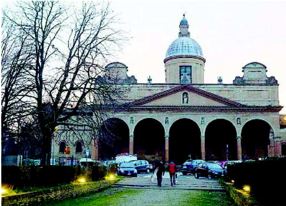
L'Asp, proprietaria del santuario del Baraccano, chiuso al pubblico dal 2012 in seguito ai danni del sisma, vuole ristrutturare la chiesa come è stato fatto con il Nettuno.
